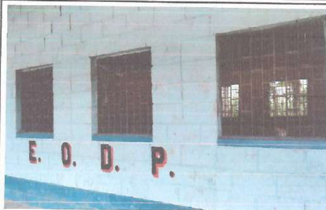
Foto 2: VENTANAS AULA Y CORREDOR
